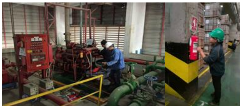
การทดสอบบั๊มน้ำดับเพลิง เครื่องสูบน้ำ หรือการตรวจสอบถึงดับเพลิง
